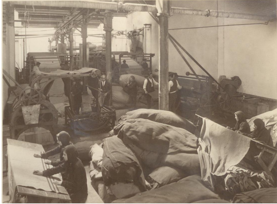
Figure 3.9 Mechanical finishing unit ( cimbız ve şardon dairesi )
