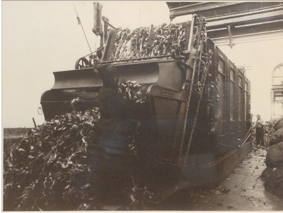
Figure 3.10 Wool fleece drying stove ( yapađı kurutma sobası )
