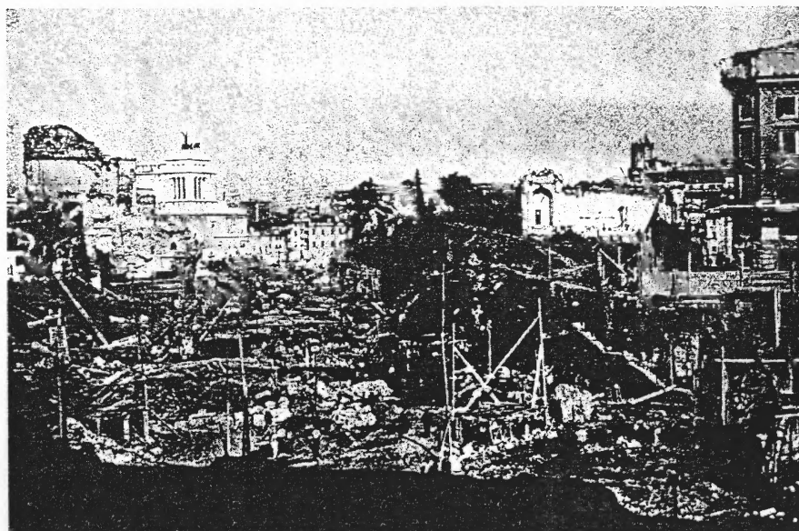
Figure 47 Demolitions in the area of future Via dei Fori Imperiali . From Giorgio Guillini. Via dei fori imperiali (Venezia: Marsilio Editori, 1983), 166.
